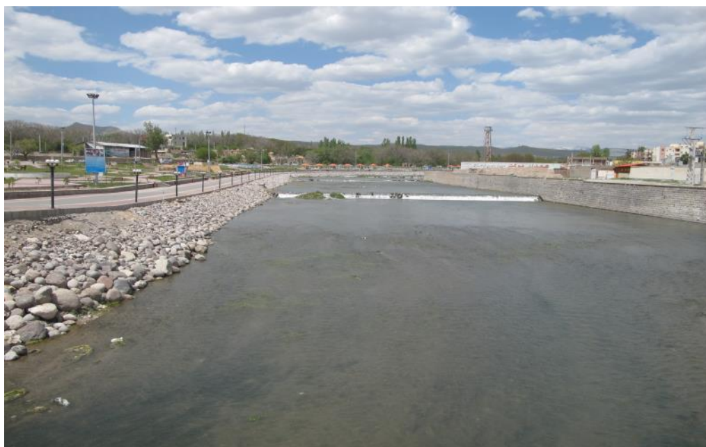
شکل (۳) تصویری از وضعیت رودخانه صوفی چای در مراغه بعد از اجرای طرح
