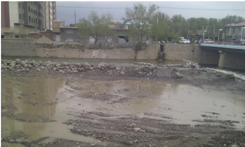
شکل (۱) تصویری از وضعیت رودخانه در بالادست پل هاشم آباد قبل از اجرای طرح
